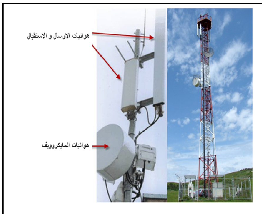
صورة (١) نموذج لبرج و هوائيات اتصالات الهاتف المحمول
